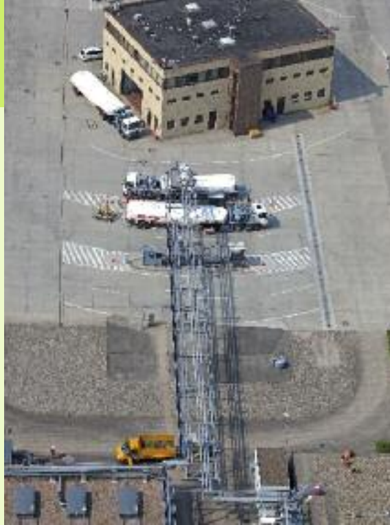
Das zentrale Kerosinlager unterliegt sehr strengen Sicherheitsvorkehrungen
