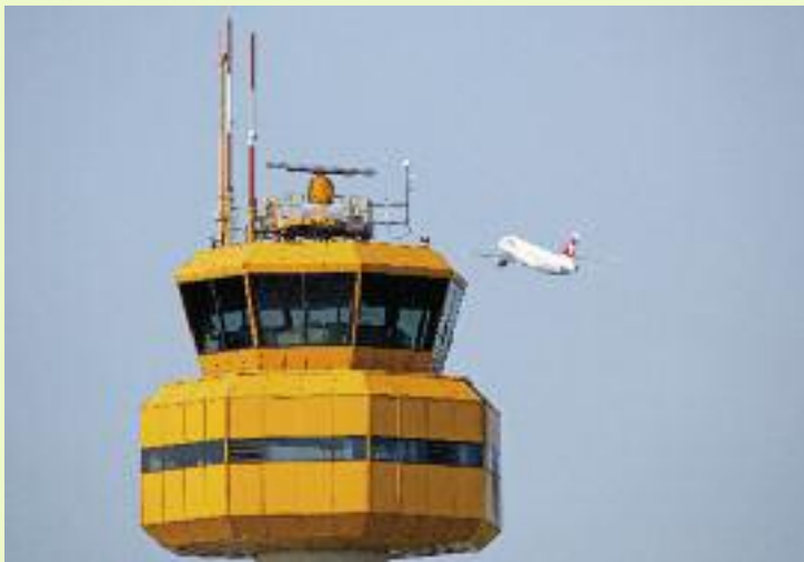
Kontrollturm der Deutschen Flugsicherung (DFS) zur Luftraumüberwachung
